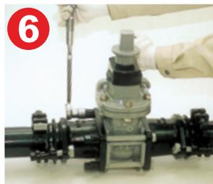
接続用六角ボルト、袋ナットを取付け、数回にわたり均等に締め付け、本締めする。
