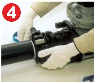
押輪とストップリングが接した状態で標線と合わせ、押輪締付ナットをパイプが仮固定するまで手締め又は軽く締める。
