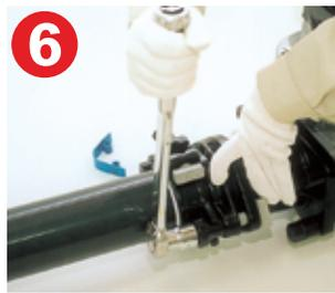
押輪締付ナットを、数回にわたり均等に締め付け、本締めする。
