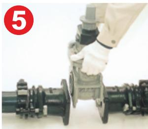
仕切弁部を、GFガスケットを再確認の上、継手部の間に取り付け、標線を目安に継手部をスライドし接続する。
