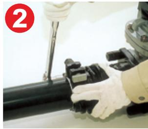
ストップリング締付部を上面にしてパイプを標線まで入れ、(手作業) 押輪締付ナットを少し緩める。
