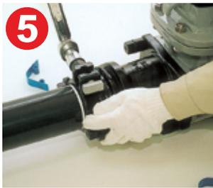
押輪と接した状態でストップリング先端があたるまで締付ナットを本締めする。(標線と重なる程度が良い。)
