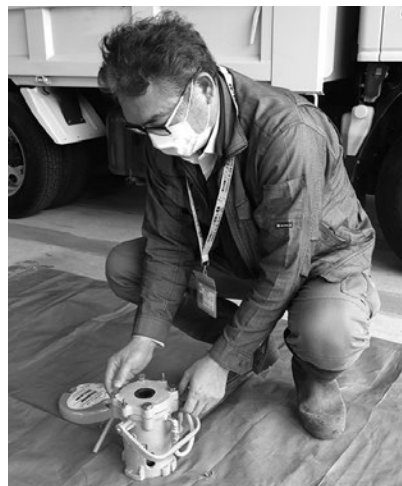
安全な場所に持ち帰り分解清掃作業を行う
